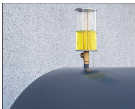
Sistema rilevamento perdite a glicole
